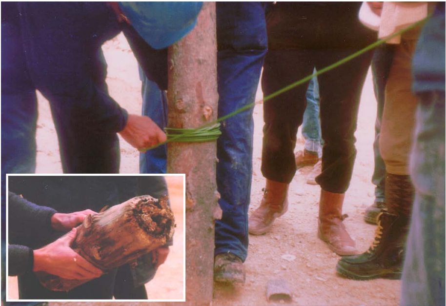
Abb. 166: Holzsprengung mit Sprengschnur
