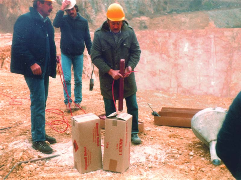
Abb. 71: Anfertig. einer 5 kg Schlagpatrone mit Sprengschnur im Steinbruch
